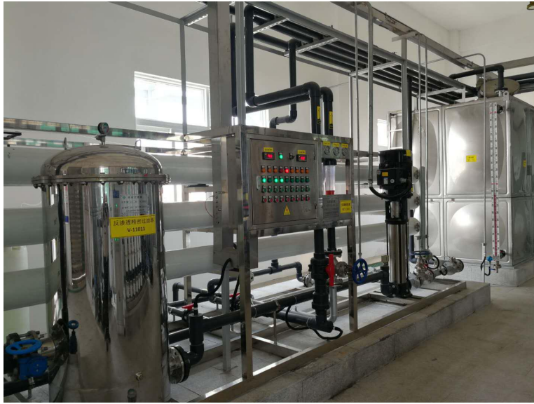
图 3-3 反渗透装置
